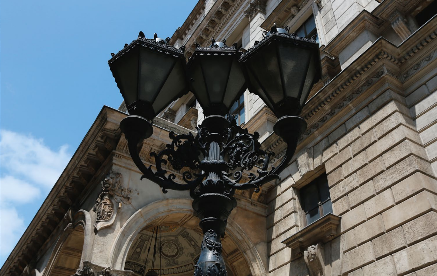
Oldalhomlokzati részlet az öntöttvas kandalóberrel
